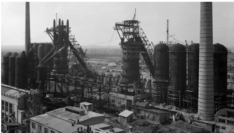
Загальний вигляд будівництва доменної печі Запорізького металургійного комбінату, 1931 рік.
